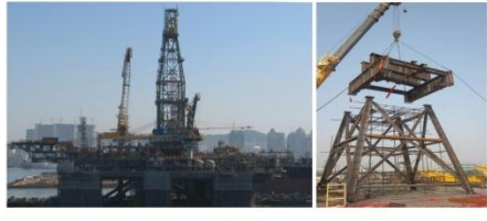
海洋钻进平台井架 Derrick for Offshore Platform
